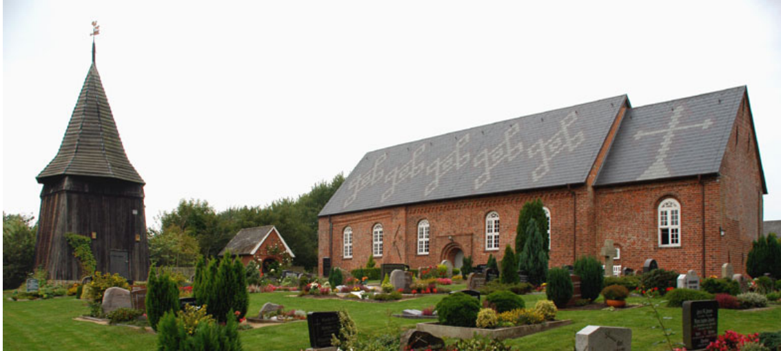
Romanische Kirche von Rodenäs mit getrennt stehendem Glockenturm aus späterer Zeit.
