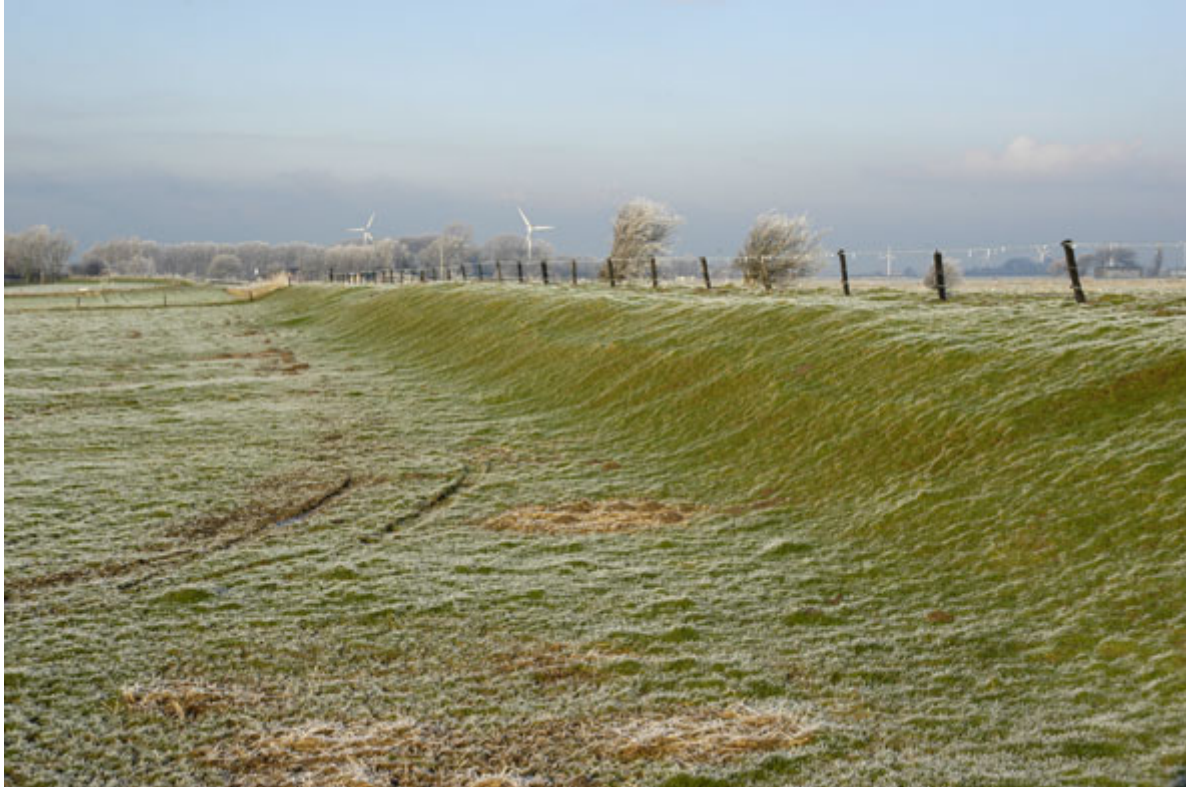
Das steile Profil eines frühneuzeitlichen Deichs bei Hellschen, südwestlich von Wesselburen.
